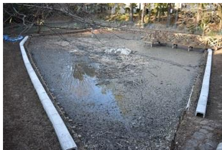
「助成金」で購入したU字溝で護岸を補強整備
