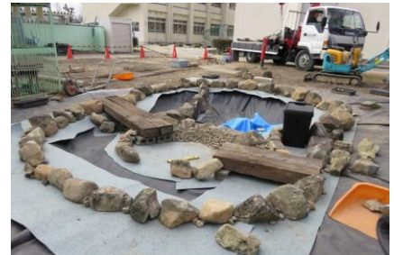
〈ビオトープ工事〉
