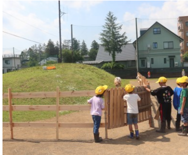
築山に柵を作っている様子
